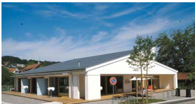
Das neue Kirchgemeindehaus Kreuzbühl.
