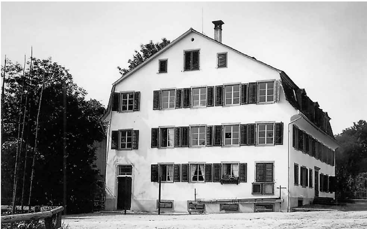
1818 als Spinnerei erbaut, von der Schulgemeinde 1842 gekauft. Nach dem Umbau im Jahr 1844 als Schulhaus eröffnet. Heute befindet sich in diesem Gebäude die Bibliothek, Mühlestrasse 1. (Foto vom 7.6.1914)
